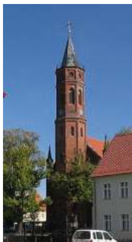
Neugotische Kirche St. Johannis, 1853 nach Plänen von Friedrich August Stüler gebaut; rechts Robert Koch-Haus
